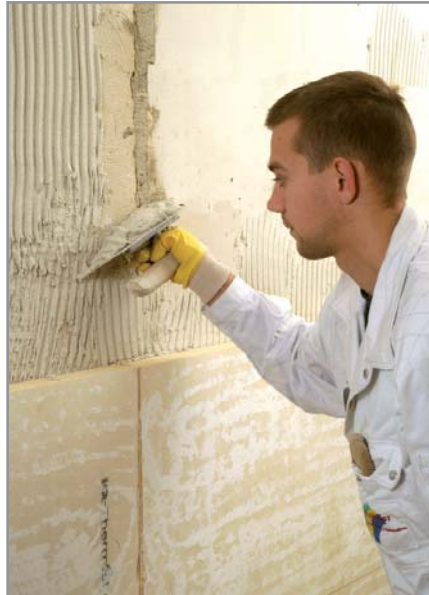
Abb. 2: Die vollflächige Verklebung von iQ-Therm-Platten erfolgt mit iQ-Fix, einem hochwertigen Klebemörtel zum Verkleben von iQ-Thermplatten. Der hydraulisch abbinde Ansetzmörtel iQ-Fix ist angepasst diffusionsoffen und kapillarleitfähig, besitzt eine hohe Klebekraft, Abrutschfestigkeit und Verbundhaftung, ist mineralfaserfrei, wasserfest, witterungsstabil, wärme- und frostbeständig.
