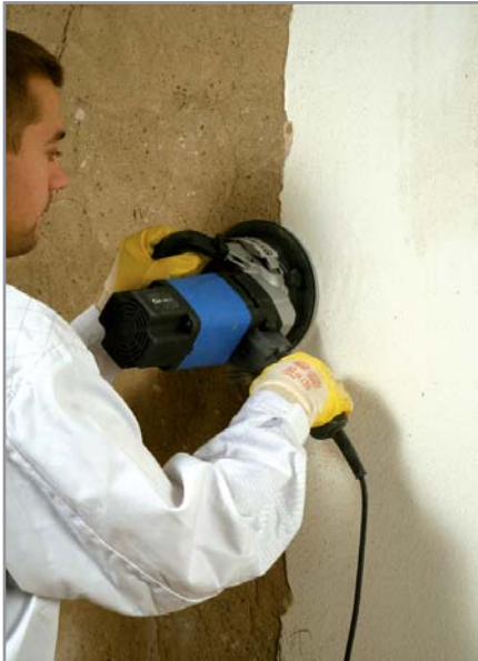
Abb. 1: Maschinelles Entfernen des Altanstriches. Der Untergrund muss fest, tragfähig und frei von trennenden, losen oder minderfesten Bestandteilen sein. Gipspachtel und Gipsputze müssen immer entfernt werden. Stark unebene Untergründe egalisieren und ausgleichen mit Grundputz, nach WTA-Merkblatt 2-9-04-D, damit eine vollflächige Anbindung des Systems gewährleistet werden kann.
