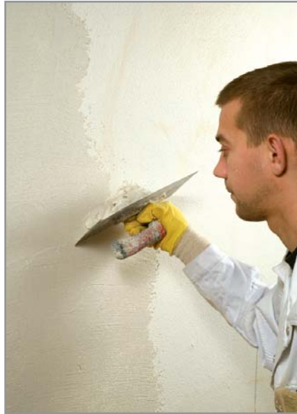
Abb. 8: Den angemischten Spachtel iQ-Fill mit Traufel aufziehen, Putzfläche abziehen bzw. abglätten und nach ca. 20 min. je nach Untergrundbeschaffenheit und Umgebungsbedingungen mit einer Holz- oder Filzscheibe bzw. Kelle in üblicher Technik bearbeiten. Die einlagige Spachteldicke soll max. 2 mm betragen.
