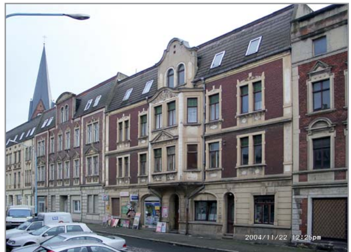
Bauvorhaben „Schäferberg“ vor der Instandsetzung
