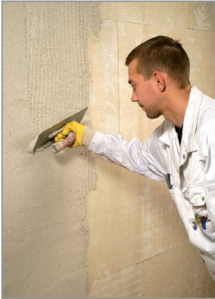
Abb. 7: Fläche mit dem Flächenspachtel abziehen. Der Auftrag der zweiten Lage Armierungs- und Oberputz iQ-Top erfolgt „frisch in frisch“ und darf eine Gesamtschichtdicke von ca. 10 mm nicht überschreiten.
