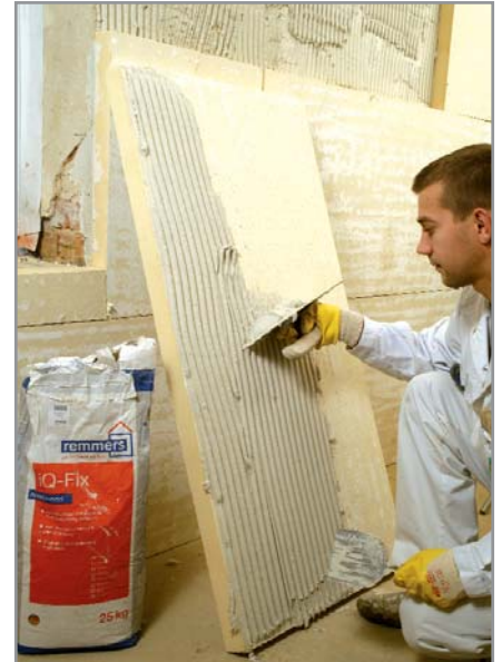
Abb. 3: iQ-Fix auf ebenem Untergrund sowie auf die Platten mittels Zahnkelle gleichmäßig auftragen (Buttering-Floating-Verfahren). Endschichtdicke mindestens 5 mm. Batzen- oder Punkt/Wulst-Verklebungen sind nicht zulässig.
