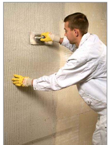
Abb. 6: Armierungsgewebe iQ-Tex mit dem Glätter in senkrechten Bahnen faltenfrei in den Mörtel einarbeiten (einzelne Gewebekanten mind. 10 cm überlappen lassen).
