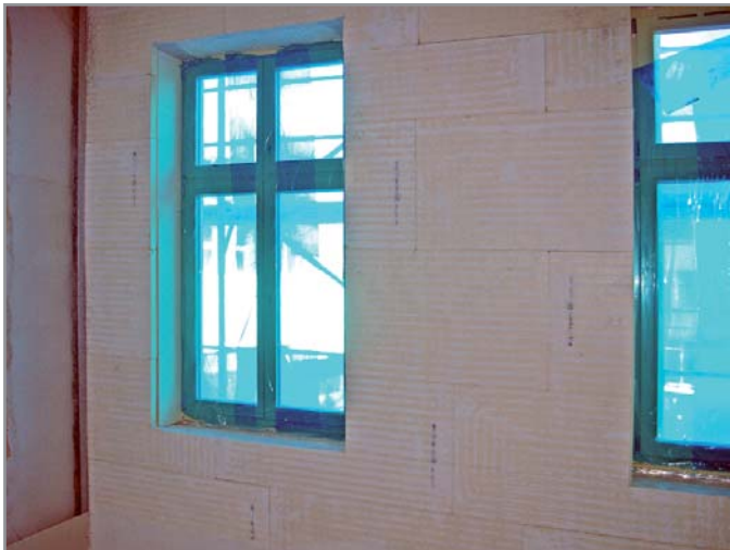
iQ-Therm-Platten montiert
