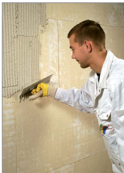
Abb. 5: iQ-Top als Armierungs- und Oberputz auf iQ-Therm mit einer Schichtdicke von ca. 5 mm mittels einer Zahnkelle 10/12 aufziehen und frisch durchkämmen.
