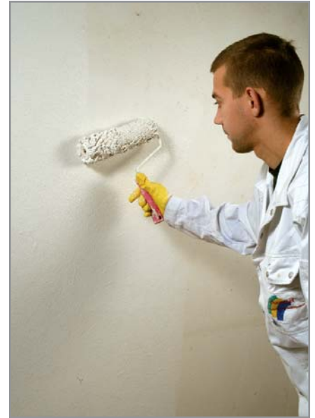
Abb. 9: Für die Endbeschichtung des iQ-Therm Systems wurde iQ-Paint entwickelt. Aufgrund der kapillaren Leitfähigkeit und hohen Wasserdampfdiffusionsfähigkeit das ideale Finish im iQ-Therm System. Durch die Alkalität der Beschichtung ergibt sich zudem ein Schutz vor Schimmelpilzbefall.
