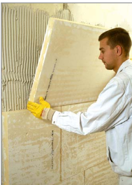
Abb. 4: Die iQ-Therm-Platten in das frische vollflächige Klebebett eindrücken und ggf. ausrichten. Kreuzfugen vermeiden! An Öffnungen die Platten ausklinken!
